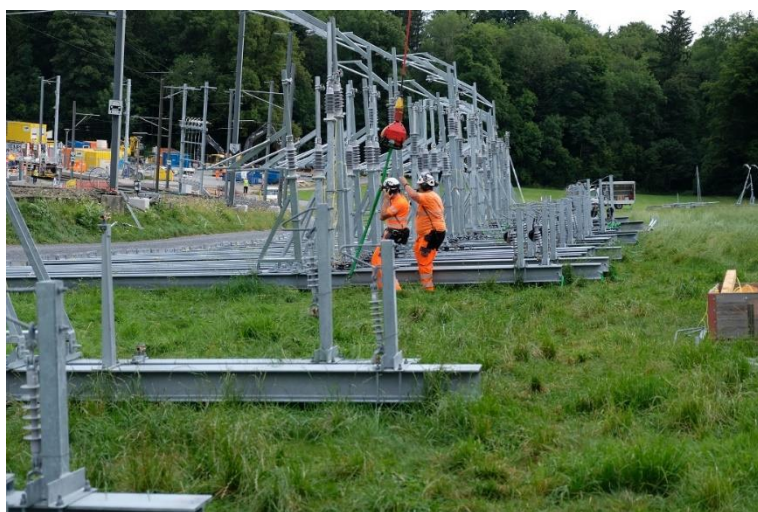
Die neuen Fahrleitungsmasten sind zum Transport mit dem Helikopter bereit.
