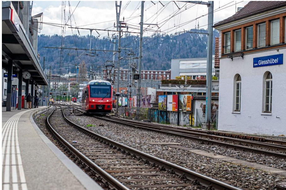
Im Bahnhof Zürich Giesshübel stehen Bauarbeiten an.
