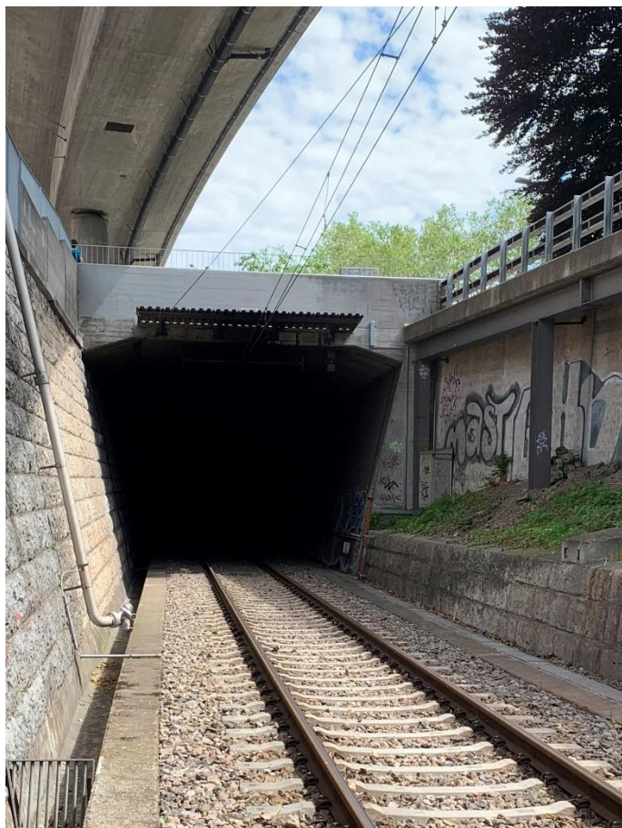
Das Tunnelportal «Giesshübel» beim Sihlhölzli.
