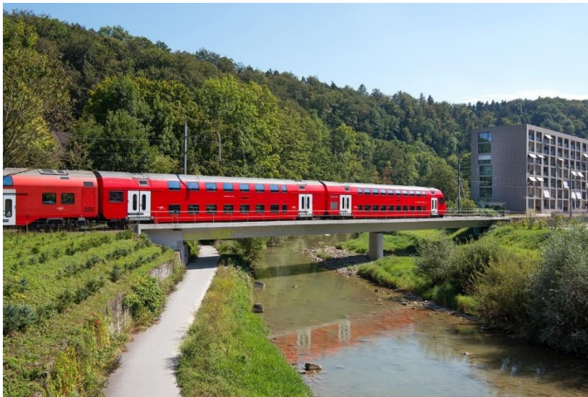
Ein Doppelstockzug der SZU auf der Maneggbrücke im Sihltal.
