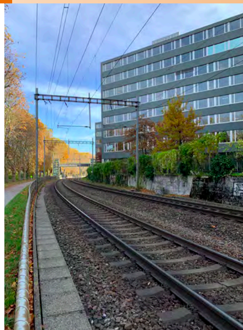
Eine neue Weichenverbindung auf Höhe des Google-Gebäudes ermöglicht einen Spurwechsel.
