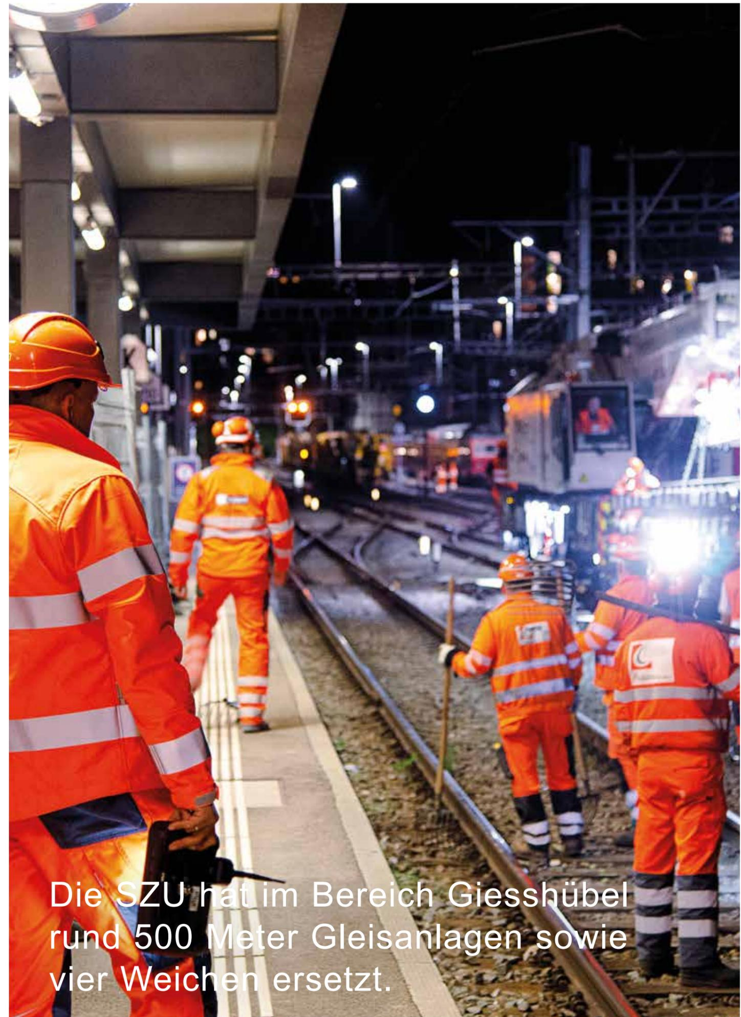
Die SZU hat im Bereich Giesshübel rund 500 Meter Gleisanlagen sowie vier Weichen ersetzt.
