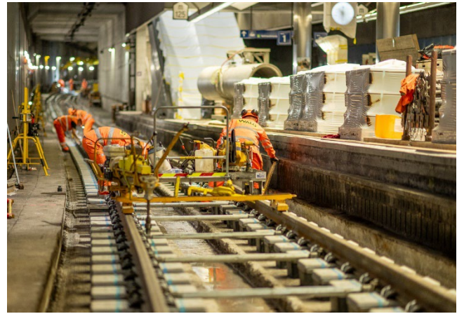
Bauarbeiten bei der Station Selnau.
