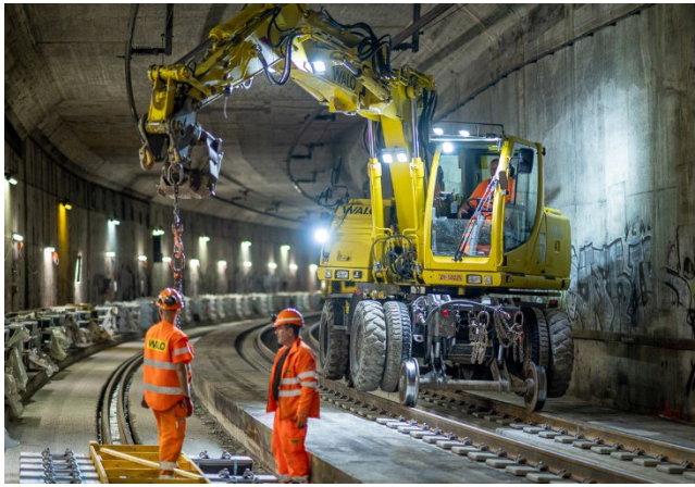
Bauarbeiten im Sihltunnel zwischen der Station Selnau und dem Tunnelportal.
