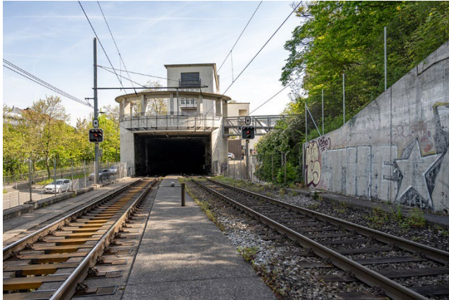
Das Portal des Sihltunnels
