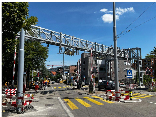
Das Kreuzungsbauwerk an der Friesenbergstrasse.
