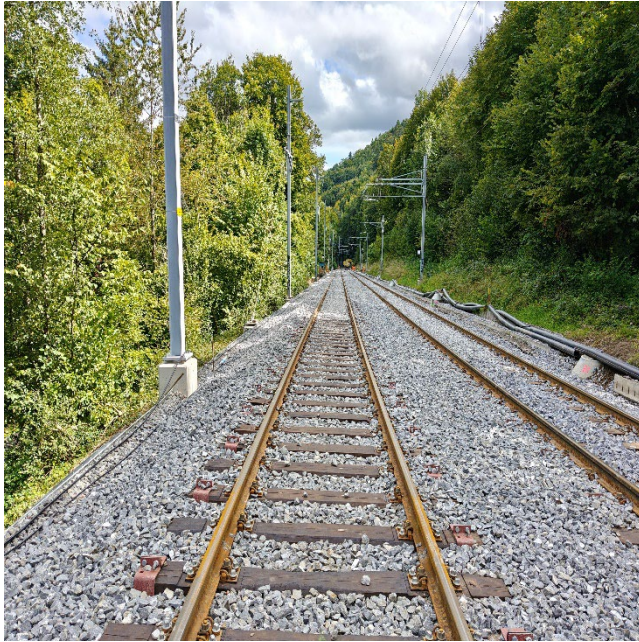
Erneuerte Fahrbahn auf der Strecke zwischen Zürich Triemli und Uetliberg, September 2025.
