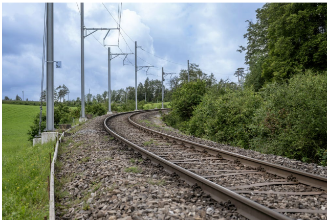
Streckenabschnitt der Uetlibergbahn S10 bei Ringlikon
